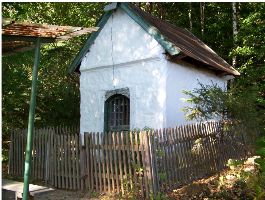
Łęki-Cisowiec, parafia Łososina Dolna. Kapliczka wzniesiona na dawnym cmentarzu cholerycznym, w 1869 r, z fundacji Stanisława Kurzydło. Z kamienia, otynkowana, kryta blachą. Na sklepieniu znajduje się malowidło Gołębicy Ducha Świętego oraz obraz Matki Bożej Dzikowskiej z 1930 roku.
