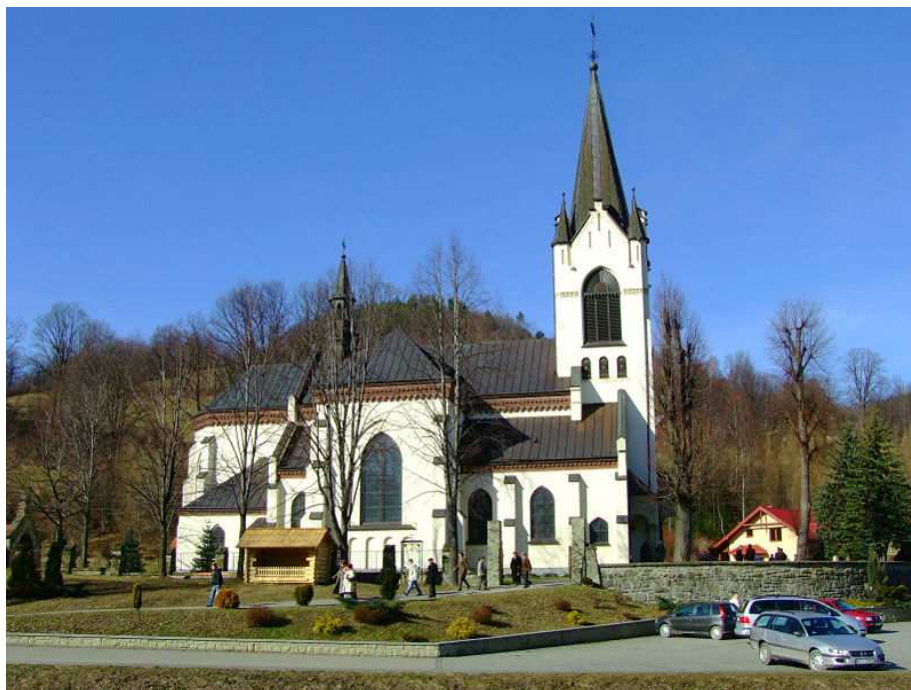
Kościół pod wezwaniem Najświętszego Imienia Maryi
